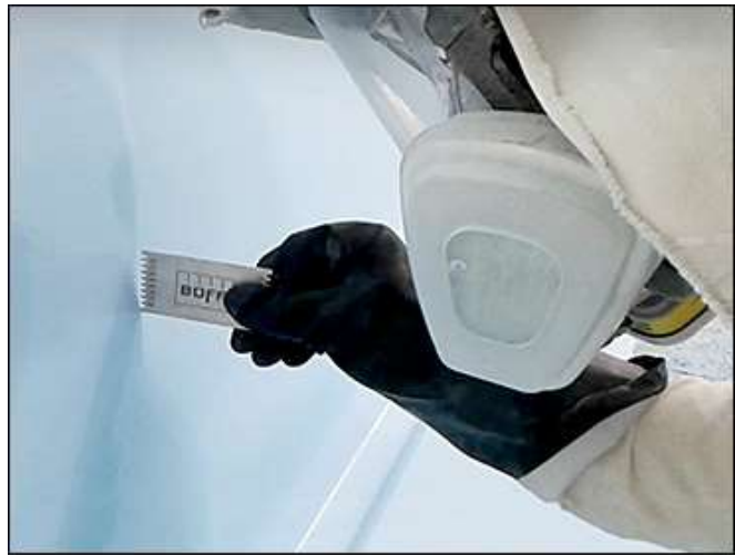
Medição da espessura do gelcoat
